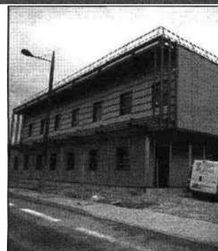
Actuellement en construction, le bâtiment sera livré cet été.
